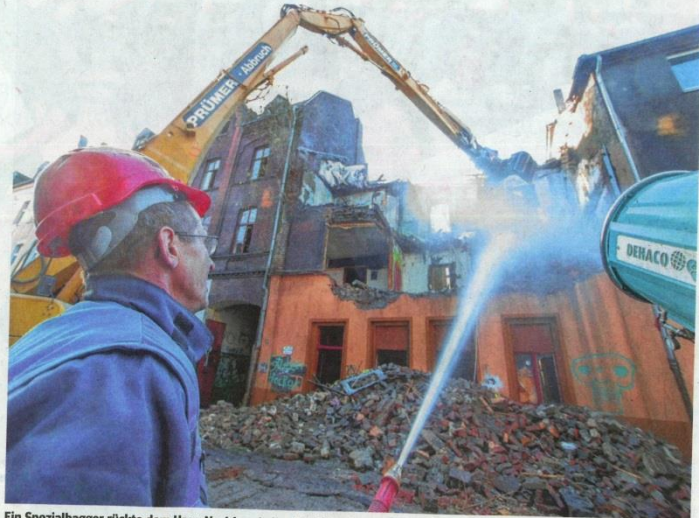
Ein Spezialbagger rückte dem Haus Nr. 44 zu Leibe. Zwei Wochen zuvor hatte die Entkernung begonnen. FOTOS: OLAF FUHRMANN
